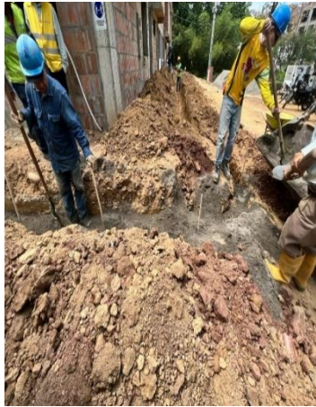
Ilustración 20, Colchón de arena para protección de la tubería de gas, Fuente: Autoría propia.
