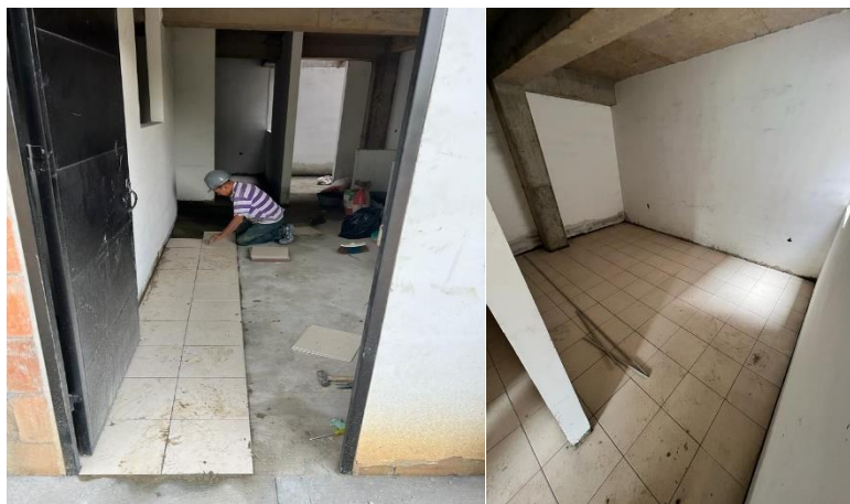
Ilustración 10, Aplicación de enchape, Fuente : Autoría propia.
