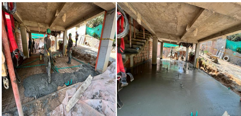
Ilustración 4, Fundida placa de contrapiso casa 13A, Fuente: Autoría propia.
