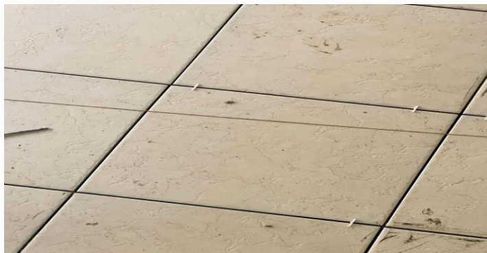
Ilustración 11, Ubicación de separadores en juntas de enchape, Fuente: Autoría propia.
