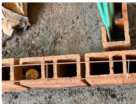
Ilustración 8, Ubicación de malla RAM en muro de mampostería, Fuente: Autoría propia
