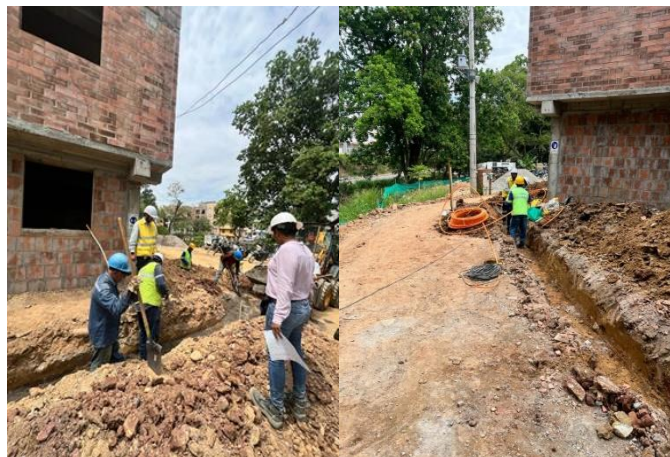
Ilustración 19, Instalación de red de gas, Fuente Autoría propia.
