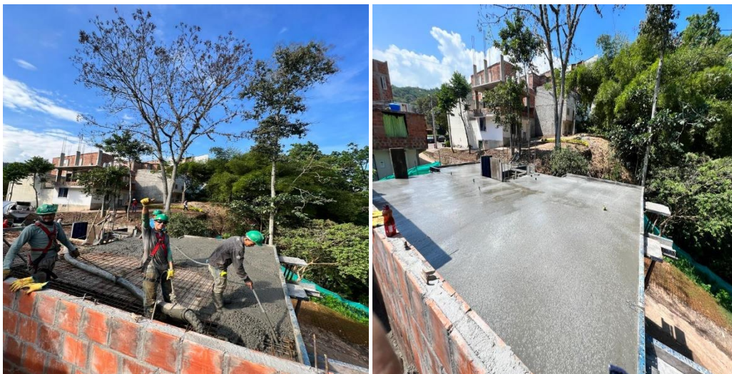
Ilustración 3, Fundida placa de contrapiso casa 13B, Fuente: Autoría propia.
