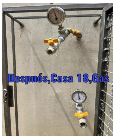
Ilustración 17, Montaje pruebas de gas Casas 18 A y 18B, Fuente: Autoría propia.
