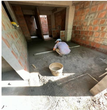
Ilustración 9, Aplicación de mortero casa 6A Manzana I, Fuente : Autoría propia.
