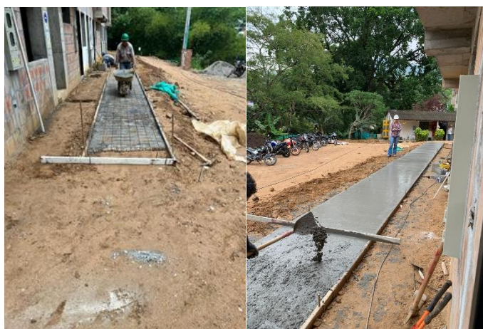
Ilustración 22, Fundida de andén, Fuente: Autoría propia.
